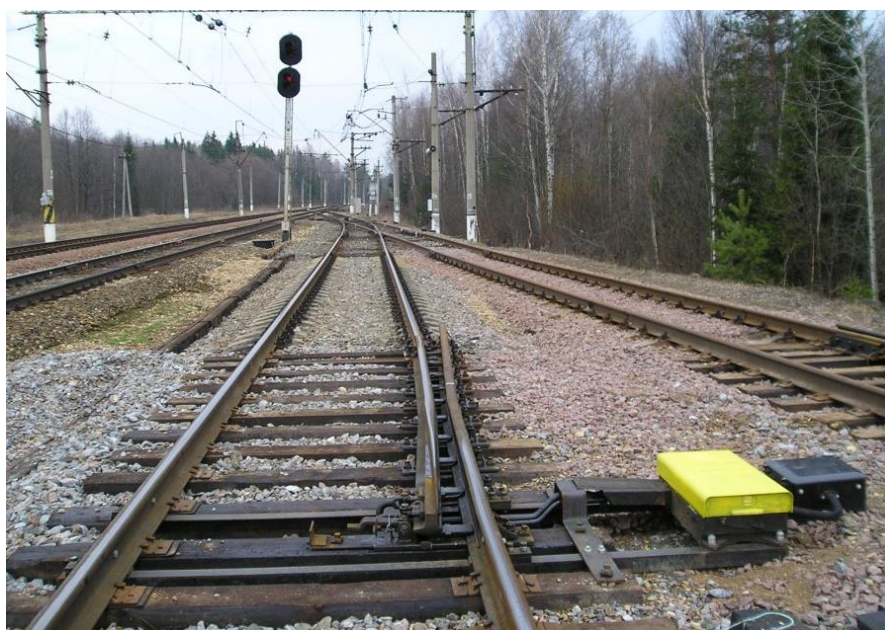
Рис. 2.5. Общий вид сбрасывающего остряка
