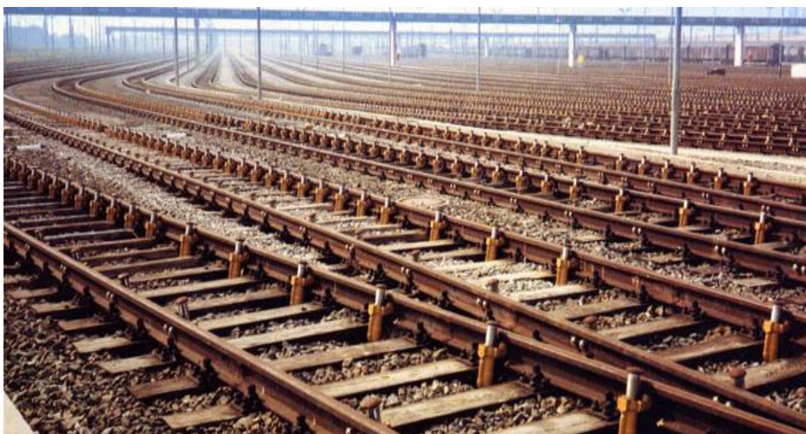
Рис. 3.23. Внешний вид точечного вагонного замедлителя КХ-НТВ-1 (ст. Забайкальск Заб.ж.д.)
