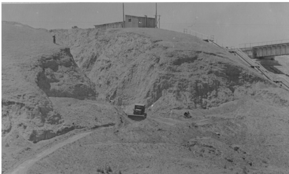
Рис. 3. Процесс работы бульдозера на стоянке Сухая Мечётка
